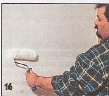
16 Нанеся равномерным слоем краску на стену, ей дают полностью высохнуть.
