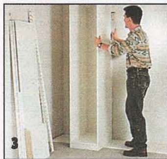
3 Расстояния между шкафами и от шкафов до смежных стен определяют с помощью укладываемых на пол готовых полок.
