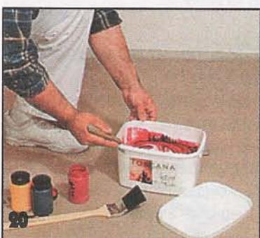
20 Добавив в эту уже разбавленную водой краску дисперсионные тонирующие краски (цвет — по желанию), полученный состав тщательно перемешивают.
