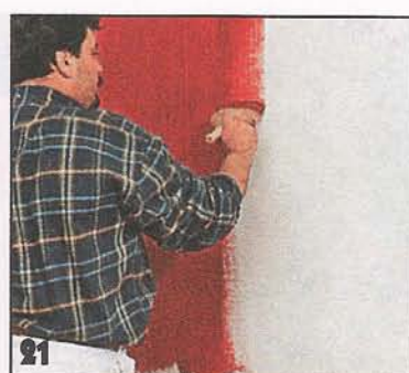
21 Кистью краску наносят на стену участками площадью 2–3 м 2 .
