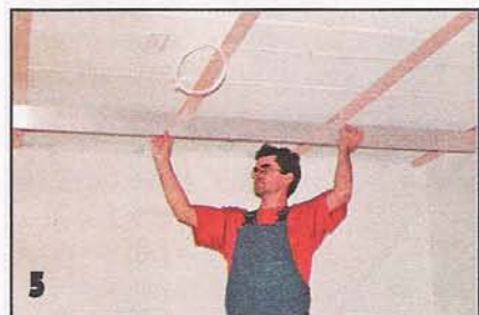
Следующие бруски крепят по той же технологии. Расстояние между базовыми брусками не должно превышать 600 мм. С помощью правила проверяют положение базовых брусков (они должны лежать в одной плоскости). Там, где имеется просвет, вывёртывают шуруп и под брусок подсовывают деревянную подкладку.
