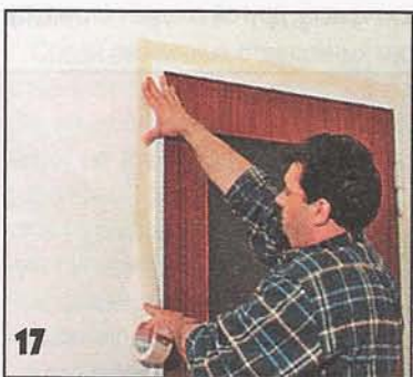
17 Участки стены по периметру дверной коробки оклеивают широкой малярной лентой.
