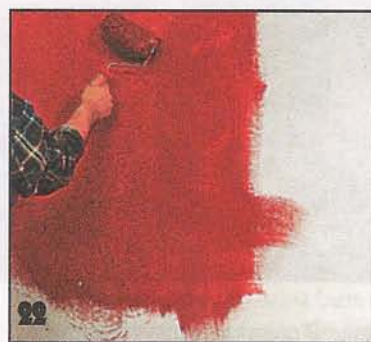
22 Сразу же после нанесения краски стену прокатывают влажным накатным валиком, работая им во всех направлениях.
