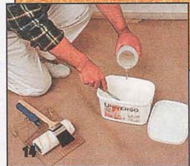
Базовую краску белого цвета разбавляют водой и тщательно перемешивают.
