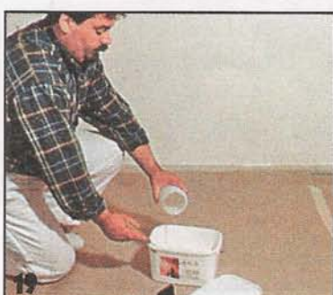
19 Структурируемую краску также разбавляют водой.
