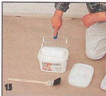
15 Валик окунают в краску и прокатывают по решётке, пока он не будет пропитан краской равномерно.
