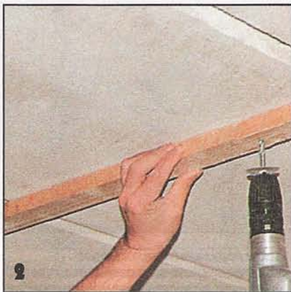
Приложив первый брусок к потолку, твёрдосплавным сверлом сверлят отверстия такого же диаметра в потолке. Чтобы пыль не попадала в патрон электродрели, на сверло надевают картонную шайбу.
