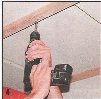
Ввернув в дюбель шуруп, последовательно устанавливают остальные дюбели.
