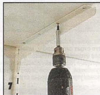
7 Полки устанавливают на полкодержатели. Особое внимание следует уделить установке полки, к которой будет крепиться откидной стол.
