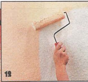
На стену наносят базовую краску и дают ей высохнуть.
