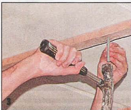
В просверленное отверстие до самого буртика осторожно забивают первый рамный дюбель.
