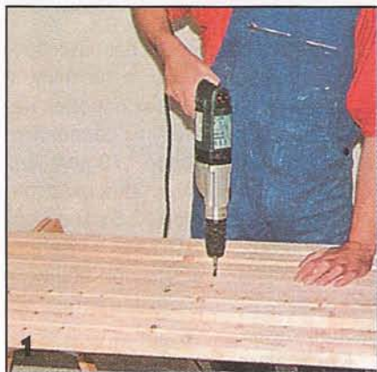
В базовых брусках обрешётки через каждые ~700 мм (но не более) сверлят отверстия \varnothing 8 мм.
