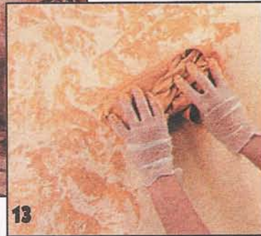
Кусок кожи окунают в контрастную краску и, свернув его в валик, равномерно накатывают краску на стену.
